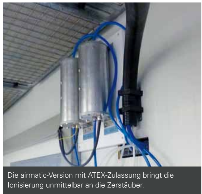
Die Installation erfolgt direkt an der Applikationstechnik der Ex-Zone.
