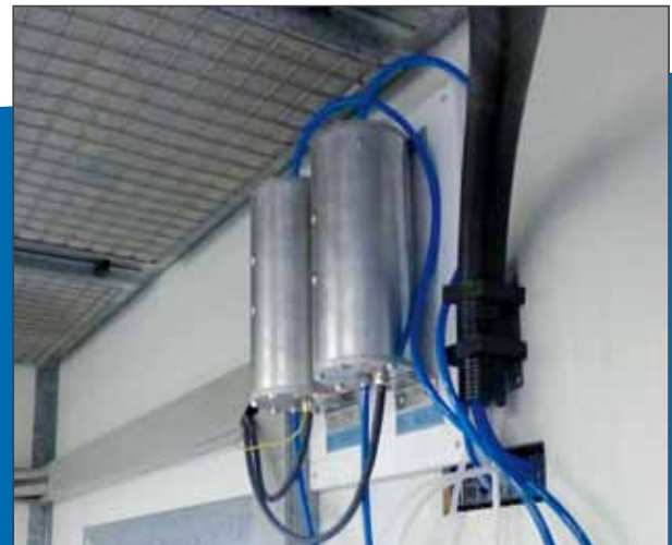
airmatic mit ATEX-Zulassung bringt die Ionisierung unmittelbar an die Zerstäuber
