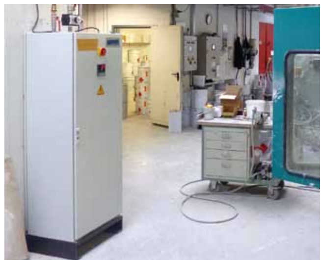
Heizen oder kühlen - airmatic optimiert die Temperatur der Zerstäubedruckluft in der Applikation
